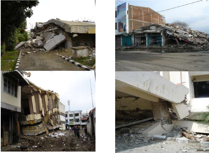
Gambar 5. Kerusakan bangunan akibat gempa Aceh 26 Desember 2004
